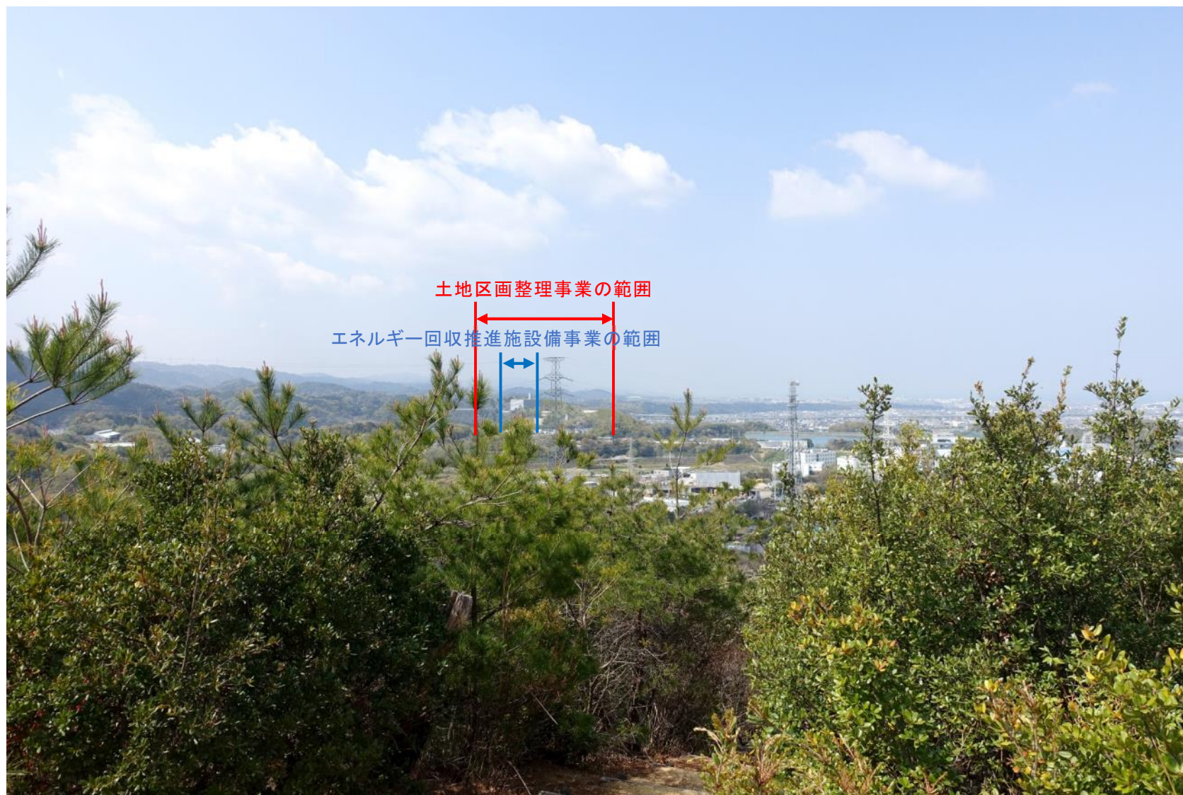
図7. 9-8(3) 和田山の予測結果(春季)【エネルギー回収推進施設等供用時】
