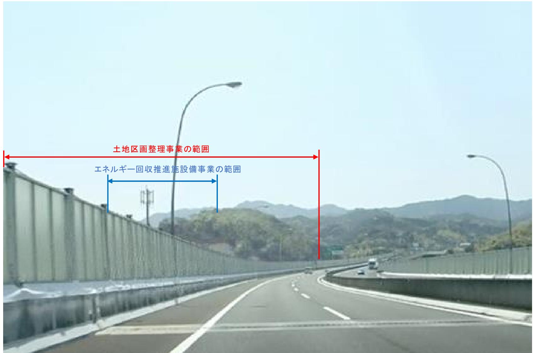
図7. 9-10(2) 関西空港自動車道の予測結果(春季)【造成工事完了後】
